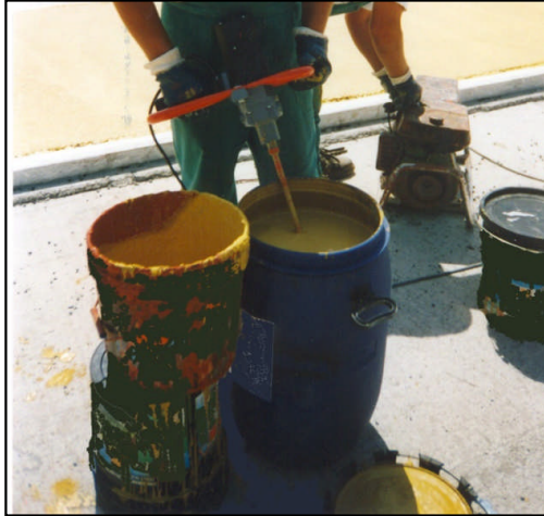
Homogenización antes de la aplicación
